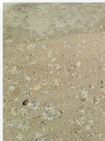
Anschleifen und Vorbereiten
